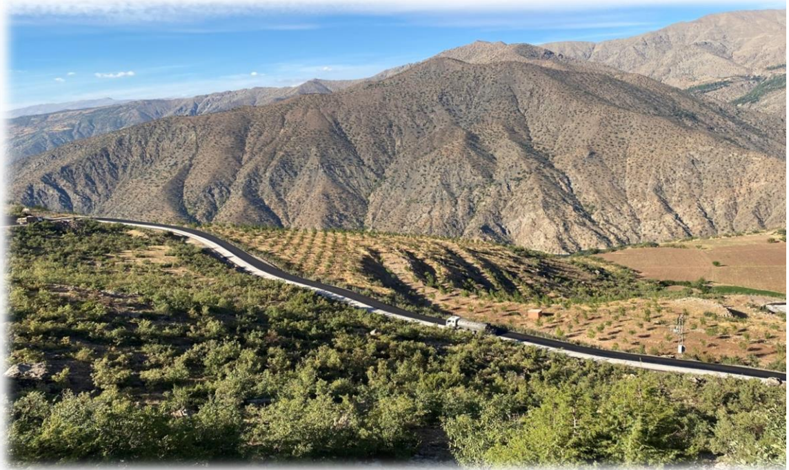
Pervari İlçesi Gökbel Çukur, Tosuntarla ve Palamutlu Grup Köy Yolları Toprak İşi-Sanat Yapıları ve 1. Kat Asfalt sathi Kaplama Yapım İşi,
